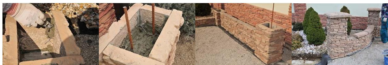
Stavbu ukončíme nalepením stípikových a múrikových čapíc. Po začistení a vytvrdení lepených spojov doporučujeme ošetrenie hydrofobizačným roztokom na betónové výrobky. Napríklad Lukofob 39 zriedený s vodou v pomere 1:10(1 diel Lukofobu a 10 dielov vody). Takéto ošetrenie jednou vrstvou chráni povrch a uľahčuje čistenie približne po dobu 5-7 rokov.
