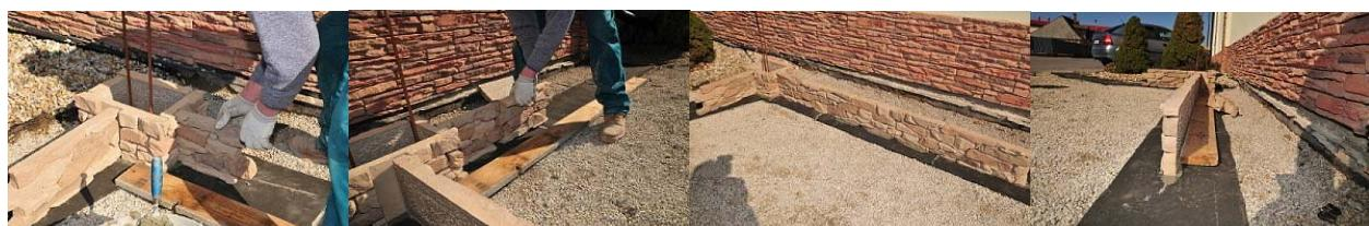
Pokračujeme v ukladaní dielov múrika v slede 0-1-2-3-4-5, pričom latou kontrolujeme horizontálnu aj pozdižnu rovnosť. Zadnú (chrbtovú) stenu múrika lepíme presne v opačnom poradí ako prednú stranu, teda v poradí 5-4-3-2-1-0 , týmto spôsobom sa jednotlivé spoje prekryjú a zaistia tak pevnosť múrika.
